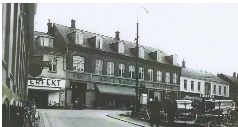
Fotografi af bygningen fra 1954. Bemærk den gamle A&G (bygning 062) til højre i billedet.
